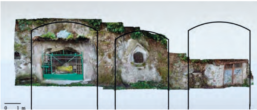
Foto 30. Anguillara (via delle rupi): fotogrammetria degli archi ciechi scavati nel tufo ( elaboraz. sulla base di rilievo Autocad: Shantidas Valli )
