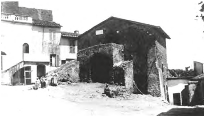
Fig. 13. Anguillara: il granaio di piazza Magnante con la rampa per accedervi in una foto del 1920 (da M. DOLCI et alii , Anguillara Sabazia e dintorni , Anguillara 2008, fig. a p. 32)
