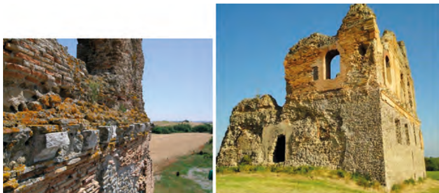
Foto 4-5. Mura di S. Stefano (‘torrione’): parte del cornicione con le sue mensole marmoree ed i suoi dentelli in laterizi (lungo il lato orientale) e vista del lato settentrionale con l’accesso murato (per seppellire i morti di colera a metà ’800)
