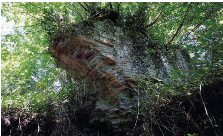
Foto 10. Loc. Calandrina: resti di arcuazioni in opera mista dell'acquedotto traiano (da R. TAYLOR, Rome's Lost Aqueduct , in "Archaeology" march/april 2012, foto a p. 40)
