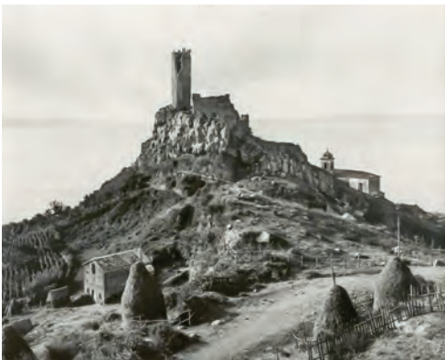
Fig. 7. Rocca di Trevignano: il mastio prima del suo crollo nel 1920 (a causa di un fulmine) (foto archivio Brogi)
